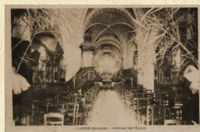
Intérieur de l'Eglise
